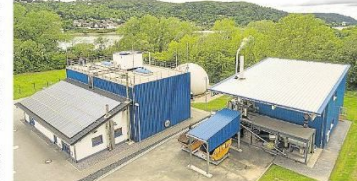
Die Kläranlage Linz-Unkel dient als gelungenes Beispiel für einen energieeffizienten Betrieb kleinerer und mittlerer Kläranlagen.
